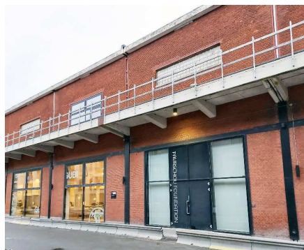
Bevaringsværdig bygning – Pakhus 53.
