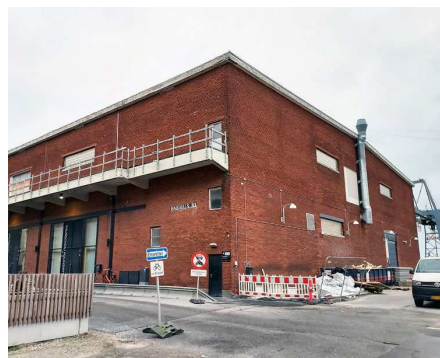
Bevaringsværdig bygning – Pakhus 53.
