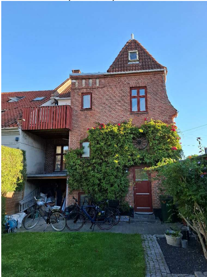
Frederikssundsvej 253, detaljer i facaden mod Kildebrøndevej 2
