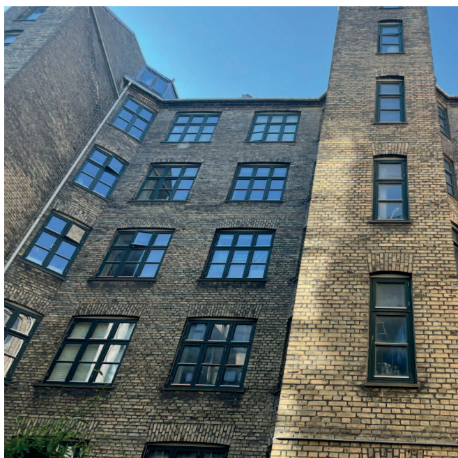
Gårdfacaden efterisoleres med Klimafacade+
