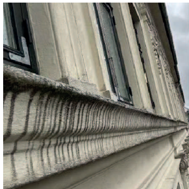
Facaden afrenses og renoveres
