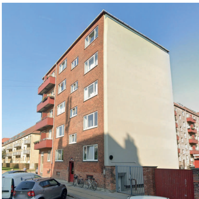
Sydvendt gavl hvor demoprojektet udføres
