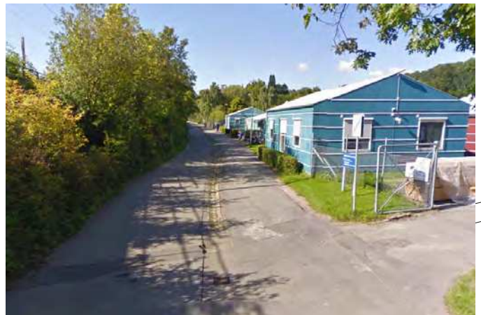
Center for Afklaring og Beskæftigelse ligger ud til Sydbanestien
