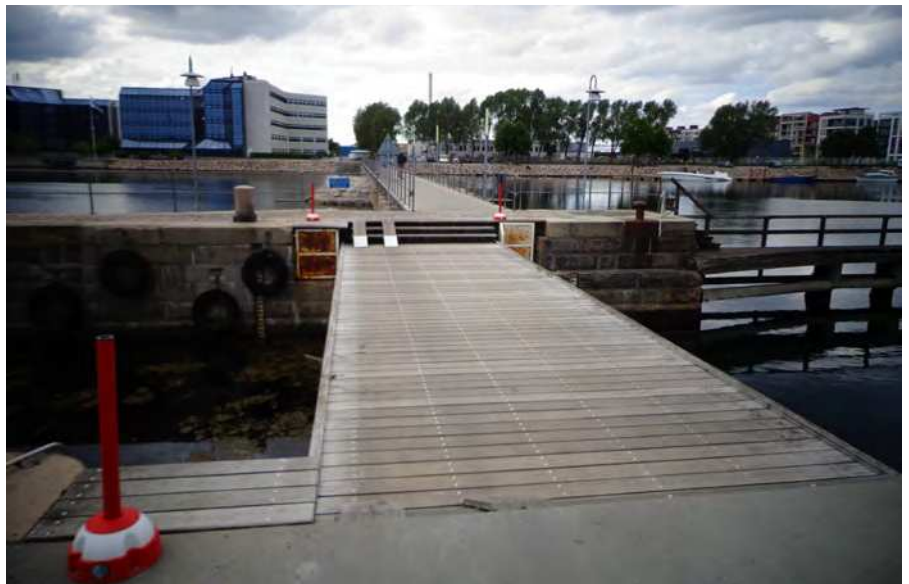
Stibroen. I den fjerne ende af broen ses trappe og rampe, som cykler kan trækkes op ad.
