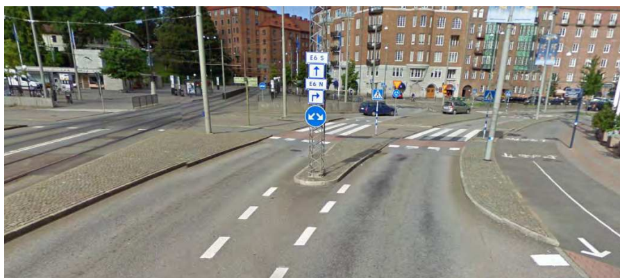
Eksempel fra Sverige, der viser fodgængerfelter over 2 kørespor i samme retning adskilt af en midterhelle
