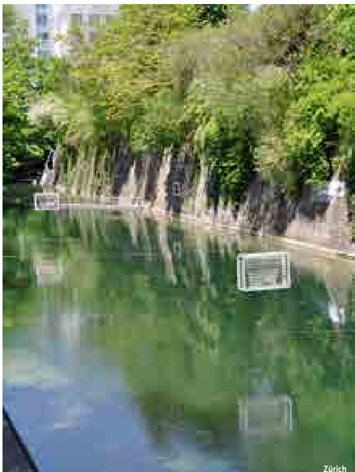
6.U Vandsport - kanal
