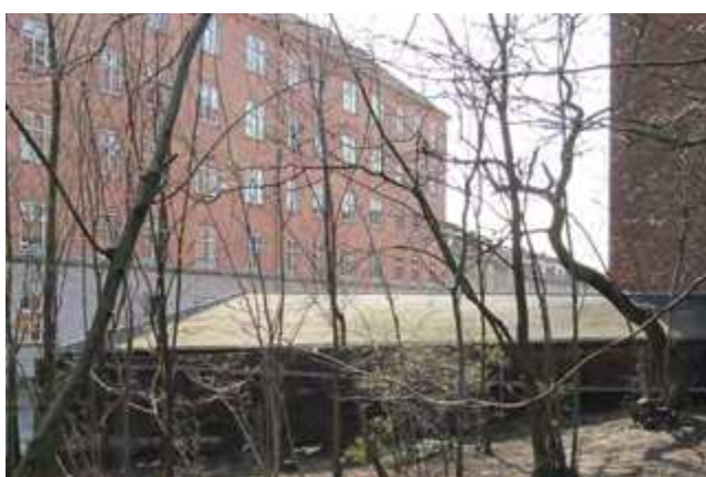
Foto 12 - Ringholmsvej set fra lokalplanområdet
