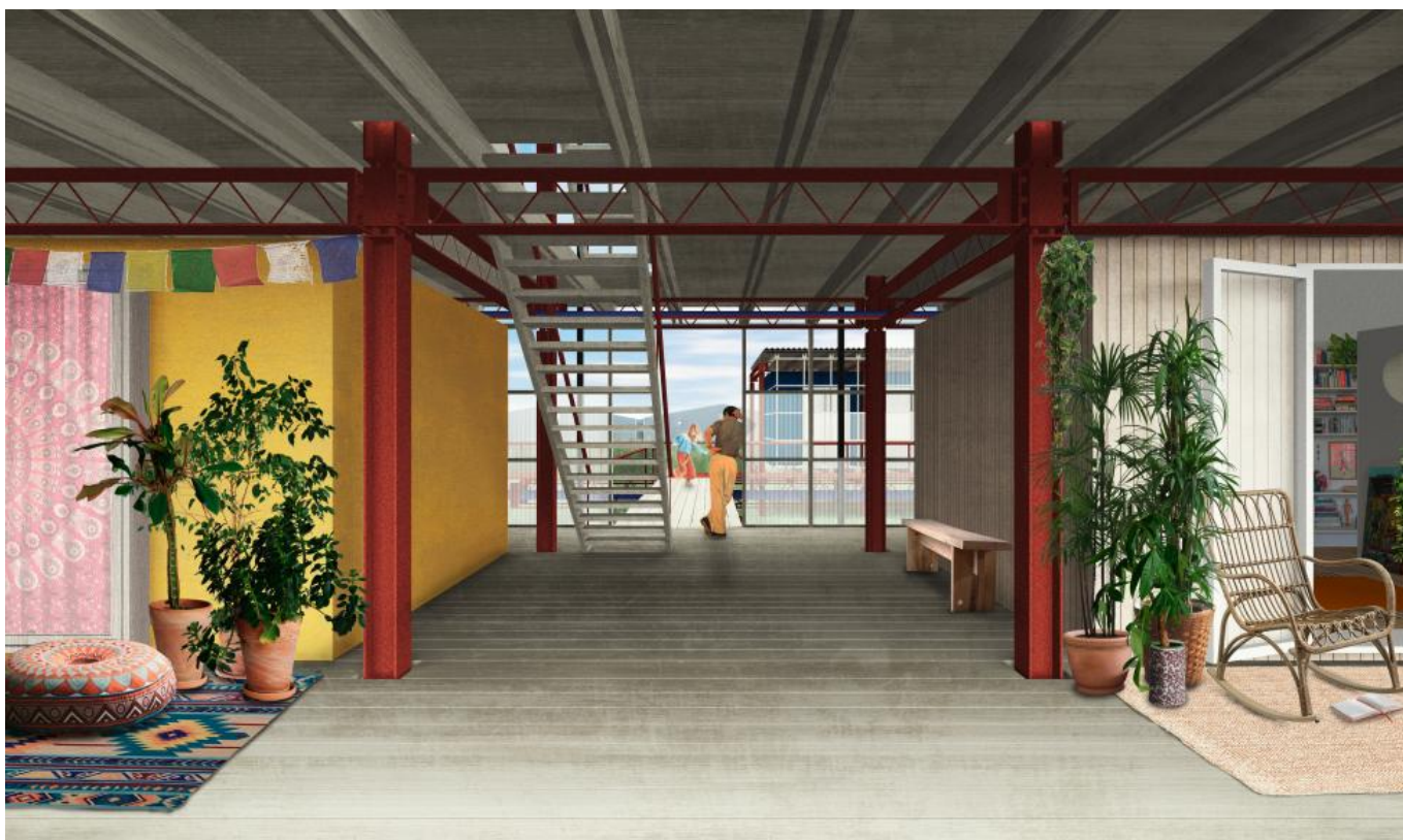
Modulbyen holdes oppe af et stålskelet, mens selve husene konstrueres i træ. Fotograf: Thorbjørn Lønberg Petersen
