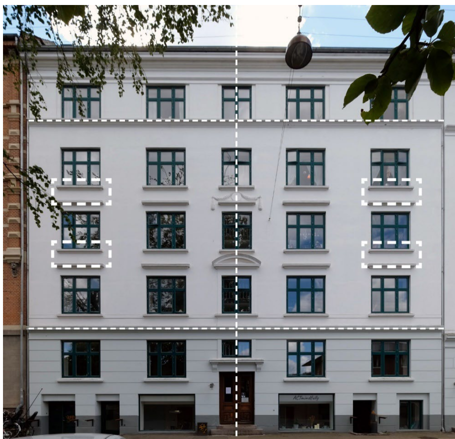
Bygning fra 1902 SAVE-værdi på 4
