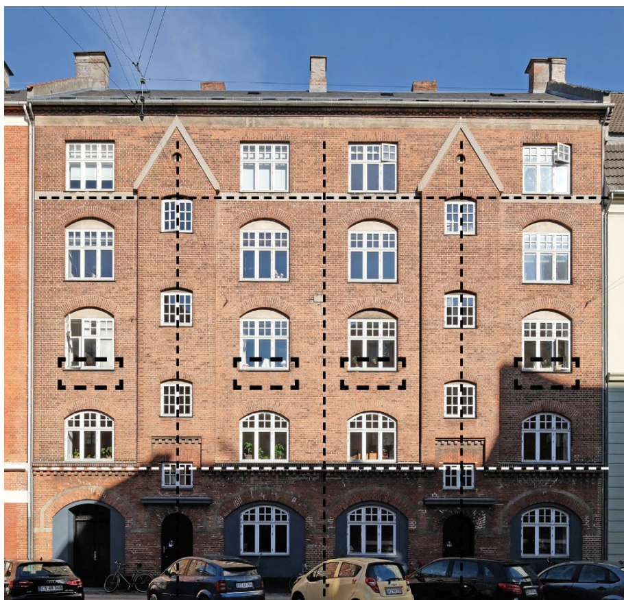
Bygning fra 1905 SAVE-værdi på 4
