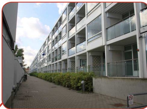
Gennemgangspassage mellem boligblokkene i det almene Ryparken.
