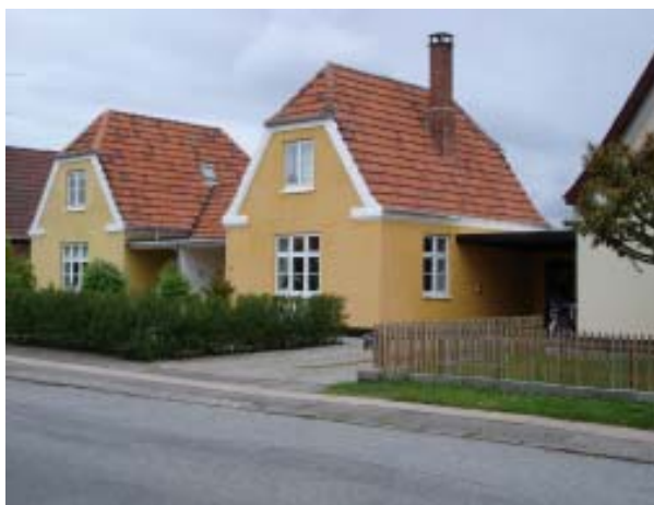
Vinduer af dannebrogstypen i sydvendt gavl med tre 3-fagsvindue i stueetagen. De sammenbyggede huse har ensartede vindfang. Den fælles carportoverdækning mellem to nabobygninger er trukket tilbage fra vejen.
