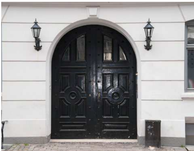
Foto 11. En rundbueport med glasudsmykning i den øverste buede del og markeret med særligt udformet slutsten.
