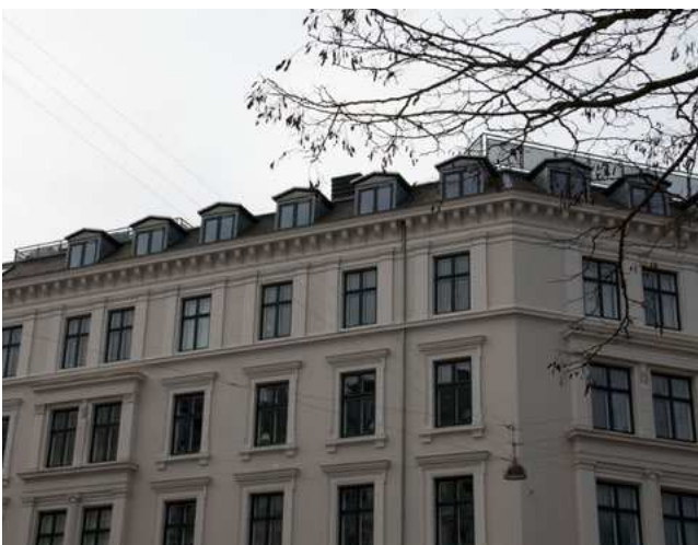
Foto 16. To tagterrasser placeret på den flade del af københavnertaget. Tagterrassen til højre er meget synlig, mens tagterrassen mod venstre er mere diskret placeret. Det er ønsket, at en tagterrasse ikke kan ses fra gadesiden.
