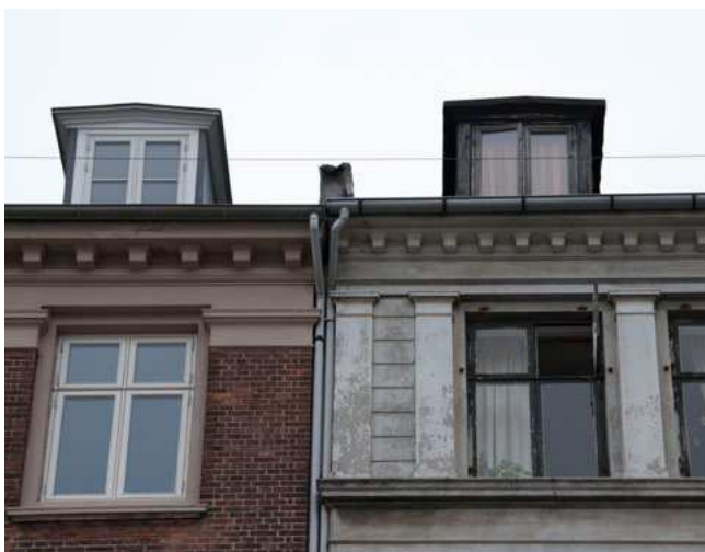
Foto 5. Mange af de oprindelige kviste i området er smalle, opført i træ med saddeltag med lav hældning. De er placeret relativt tæt og rytmisk, uden hensyntagen til underfacadens symmetrisk placerede vinduer.
