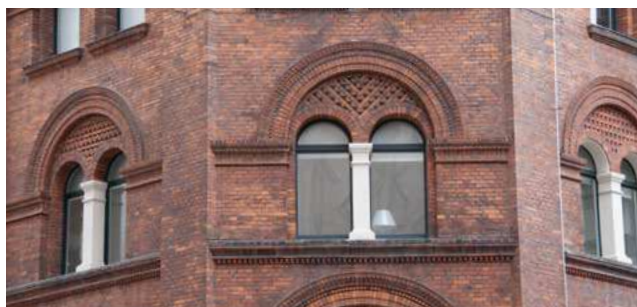
Tordenskjoldsgade 1 er et eksempel på den danske pendant til den tyske Rundbogenstil, rundbuestil.
