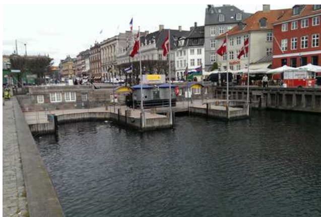
Landingspladsen med trappeanlægget, hvor der er påbygget en træbrygge med mulighed for 3 anløb.
