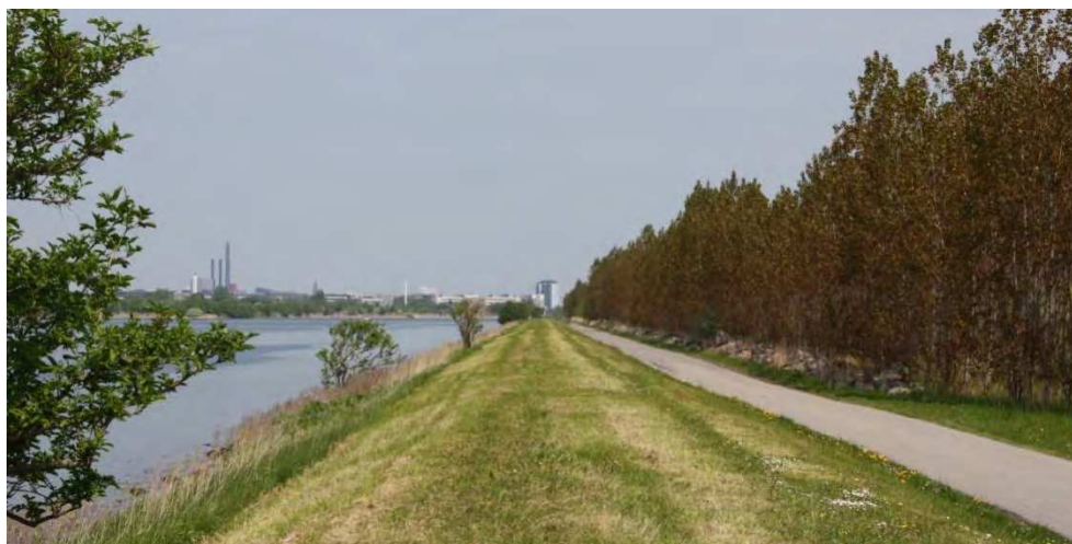
Figur 7.1 Promenaden langs Kalvebodløbet ind mod København. Den sydlige del af Kalvebod Miljøcenter ligger bag træerne til højre i billedet.
