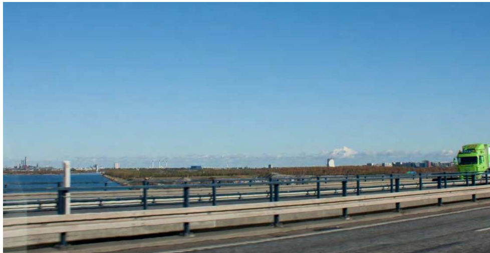
Figur 9.11a Fra Kalvebodbroen uden møller, fotostandpunkt 4.
