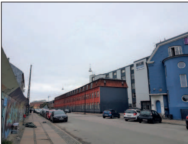
Eksisterende boligbebyggelse set fra Aldersrogade
