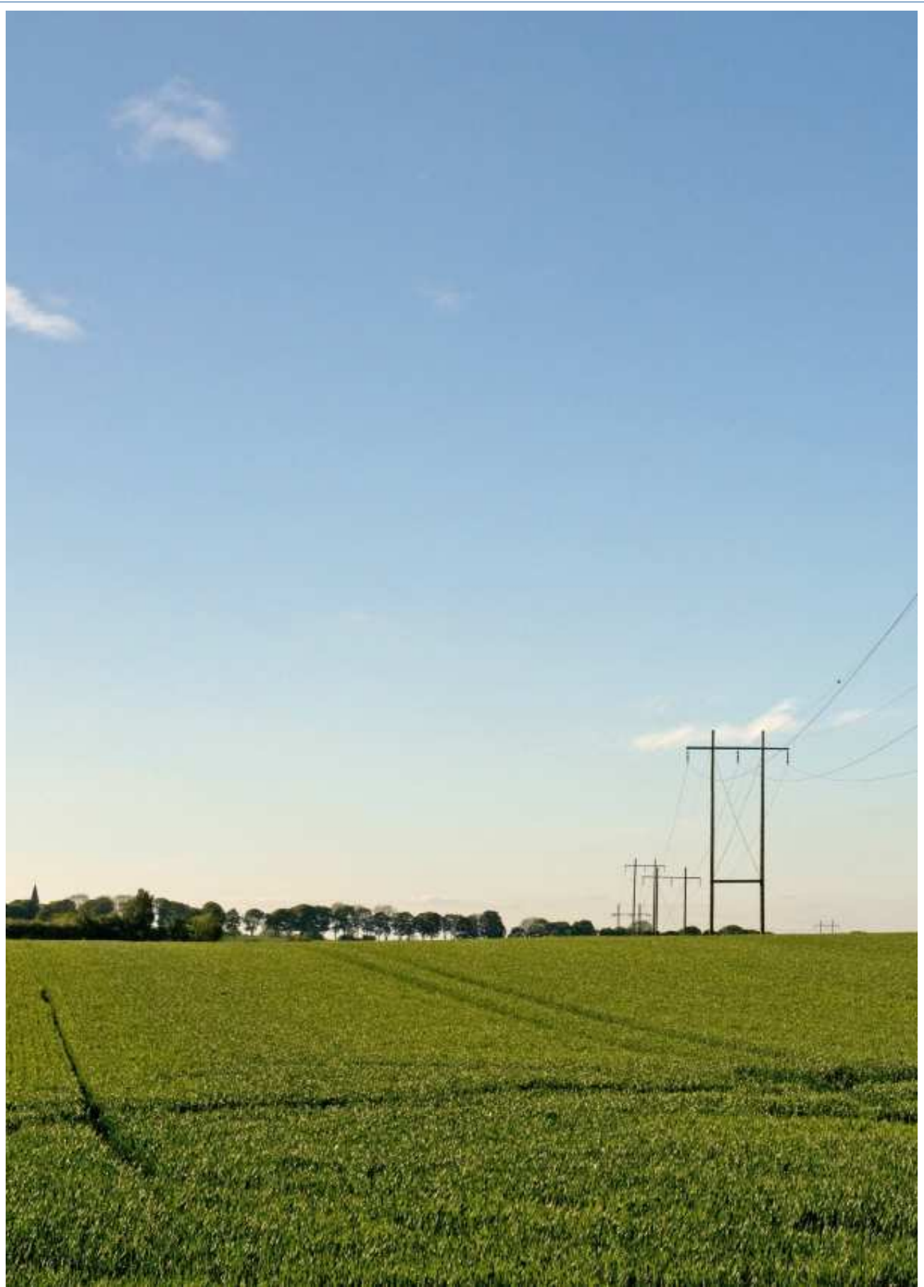
En ældre 60 kV ledning på træmaster. Flere og flere af disse ledninger vil blive lagt i jordkabler i de kommende årtier.
