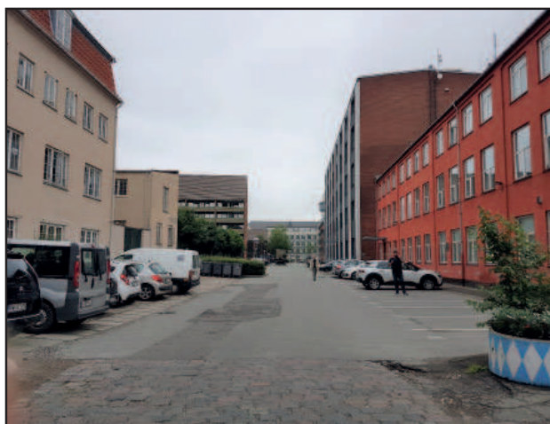
Området ved Hammershusgade
