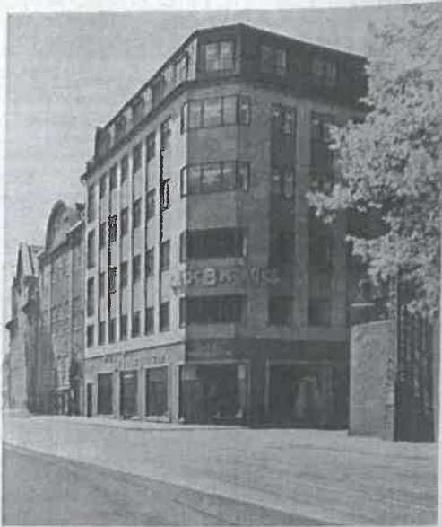
Sven Risom: Forretningsbygning paa Nørregade
