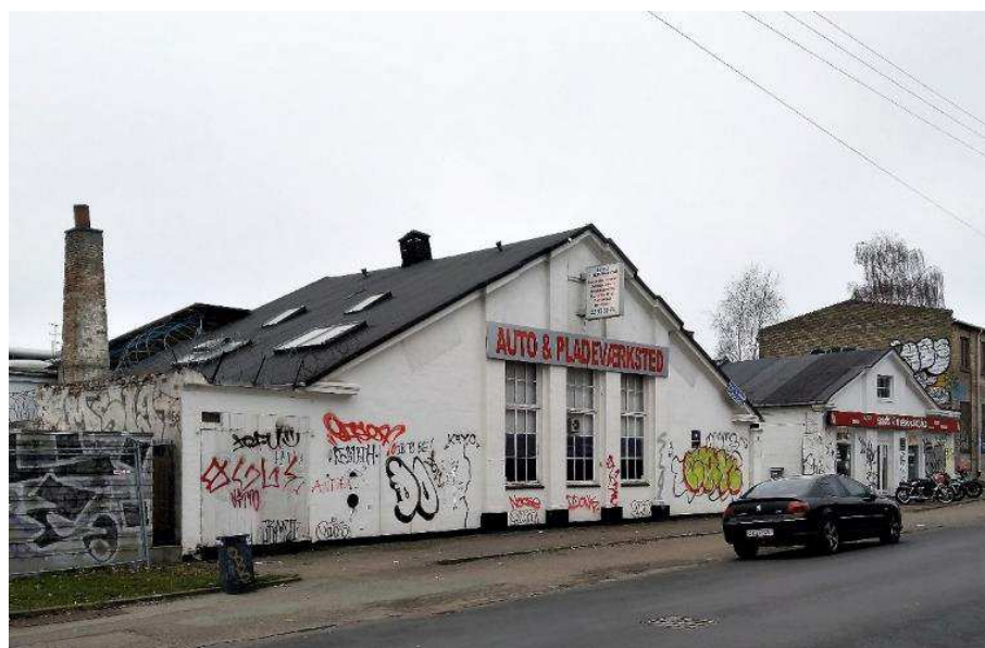
Karakteristiske værkstedsbygninger mod Rentemestervej der, bevares.
