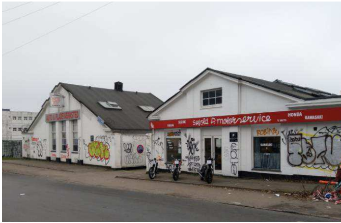
Karakteristiske værkstedsbygninger mod Rentemestervej der, bevares.
