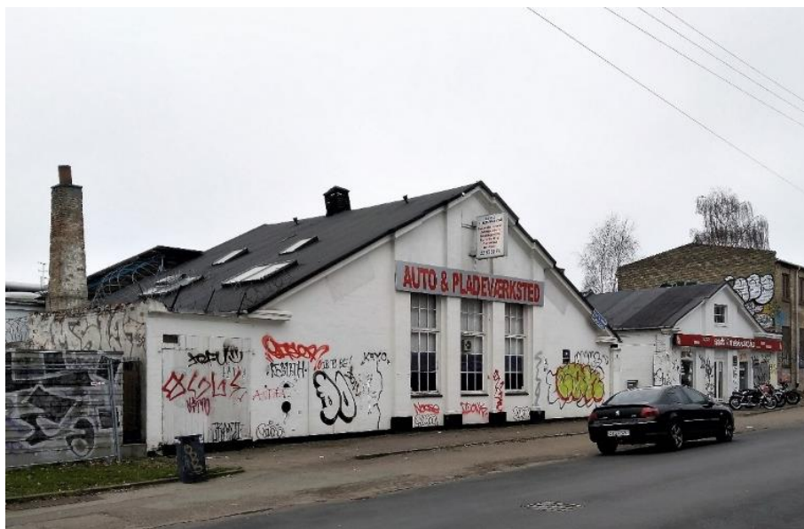
Karakteristiske værkstedsbygninger mod Rentemestervej der, bevares.
