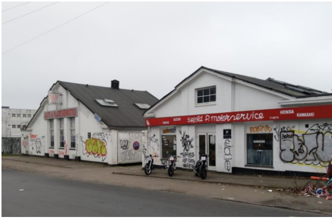
Karakteristiske værkstedsbygninger mod Rentemestervej der, bevares.
