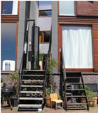
Boliger i stueetagen med trapper. Reference: Amsterdam.
