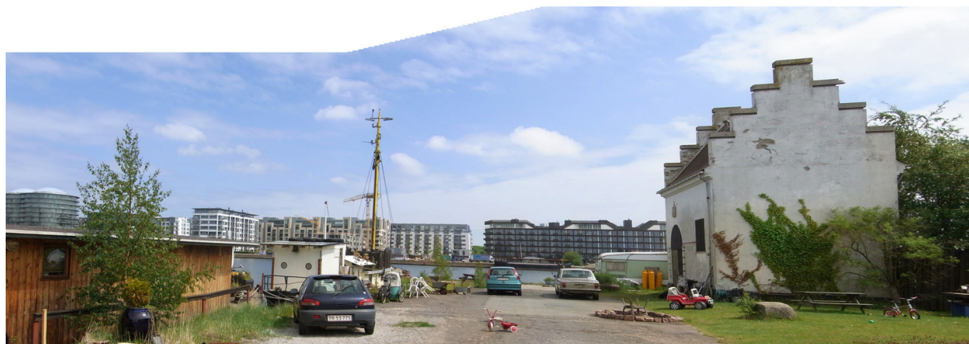
Den nordøstlige spids af Enghave Brygge med udsigt til Islands Brygge. Den hvide bygning, der bevares, anvendes til pumpestation.
