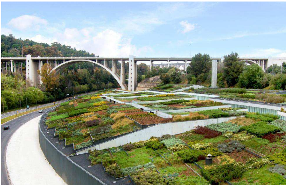
Figur 2-M: En grøn overdækning fungerer som regnvandshåndtering. © Nexclay
