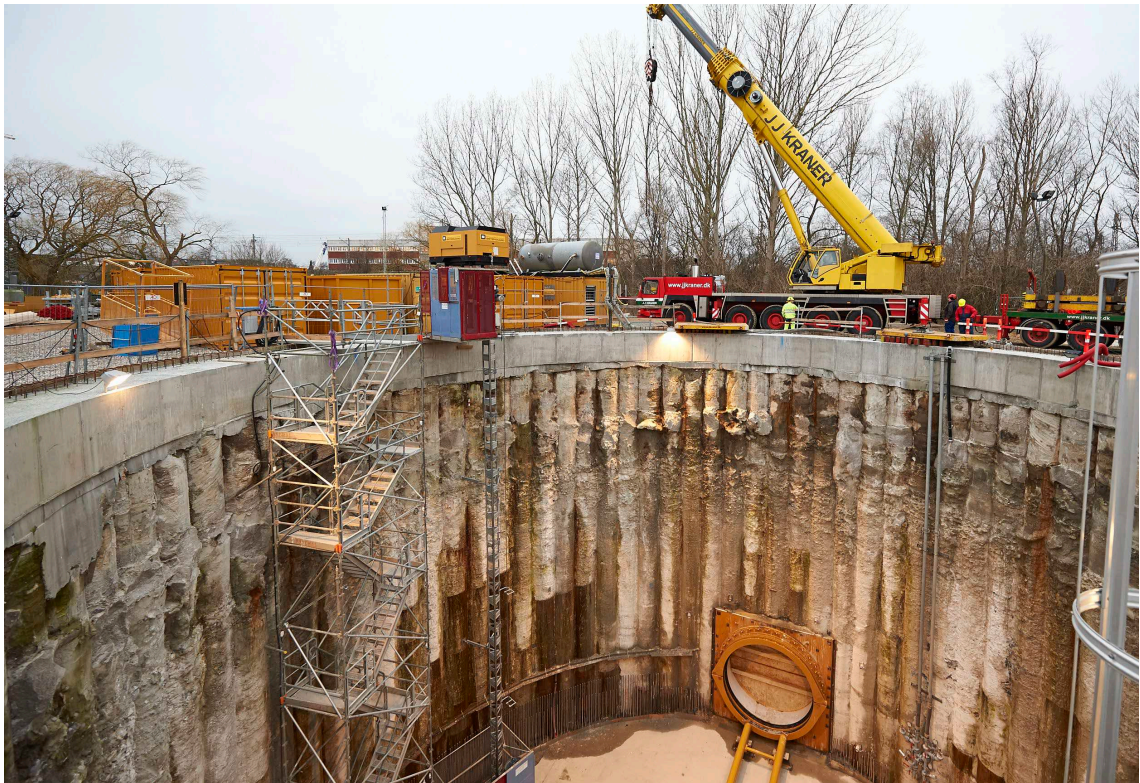
Figur 5.8: Skakt udført med sekantpælevæg
