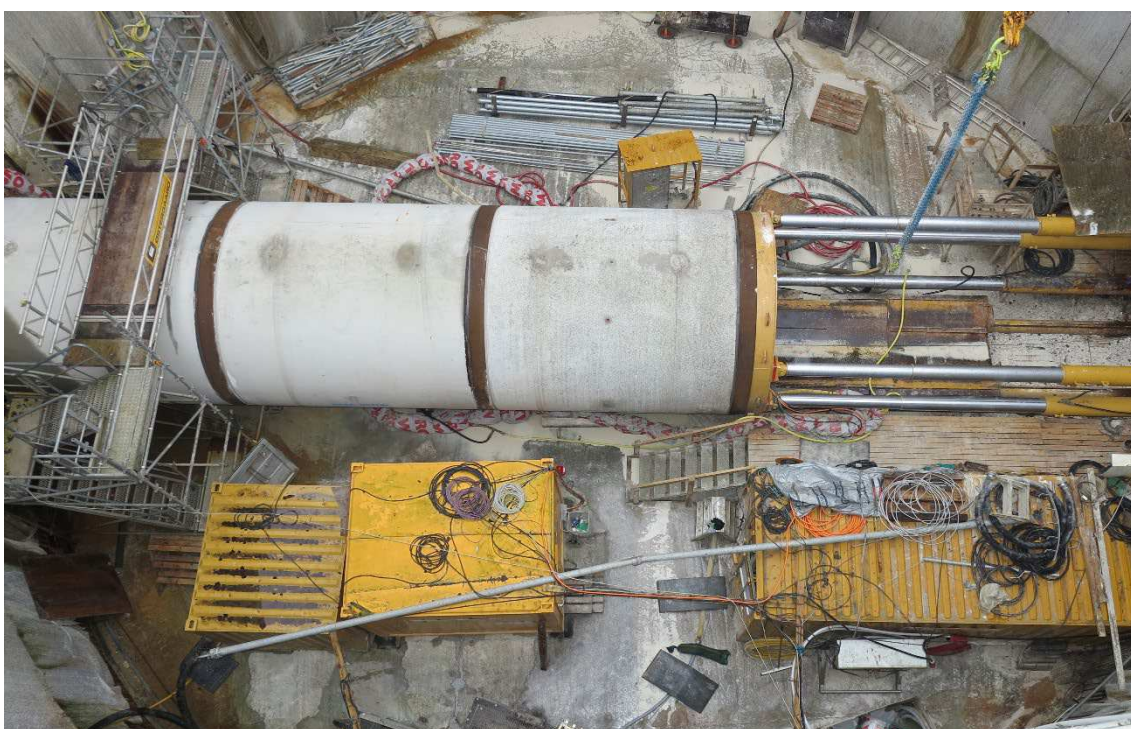
Figur 5.14: Skakt (pressegrube) set fra oven, hvor betonelementerne presses ind i tunnelen (pipejacking).
