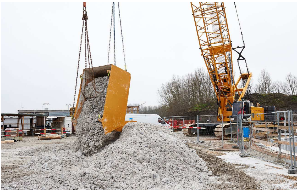
Figur 5.10: Tunnelmuck hejses op fra skakten til bortkørsel.
