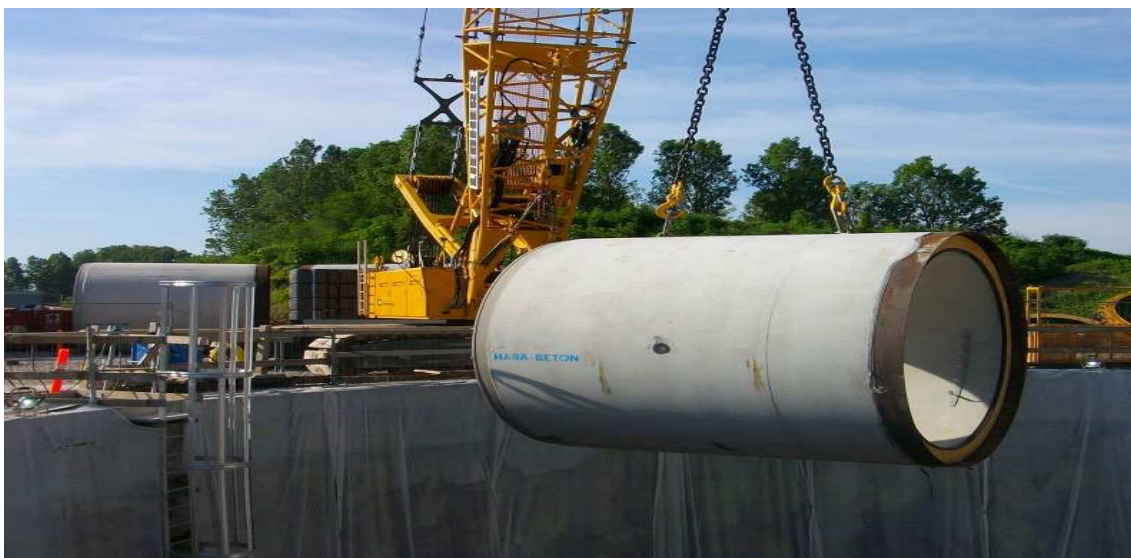
Figur 5.13: Tunnelrør nedsænkes i skakten.
