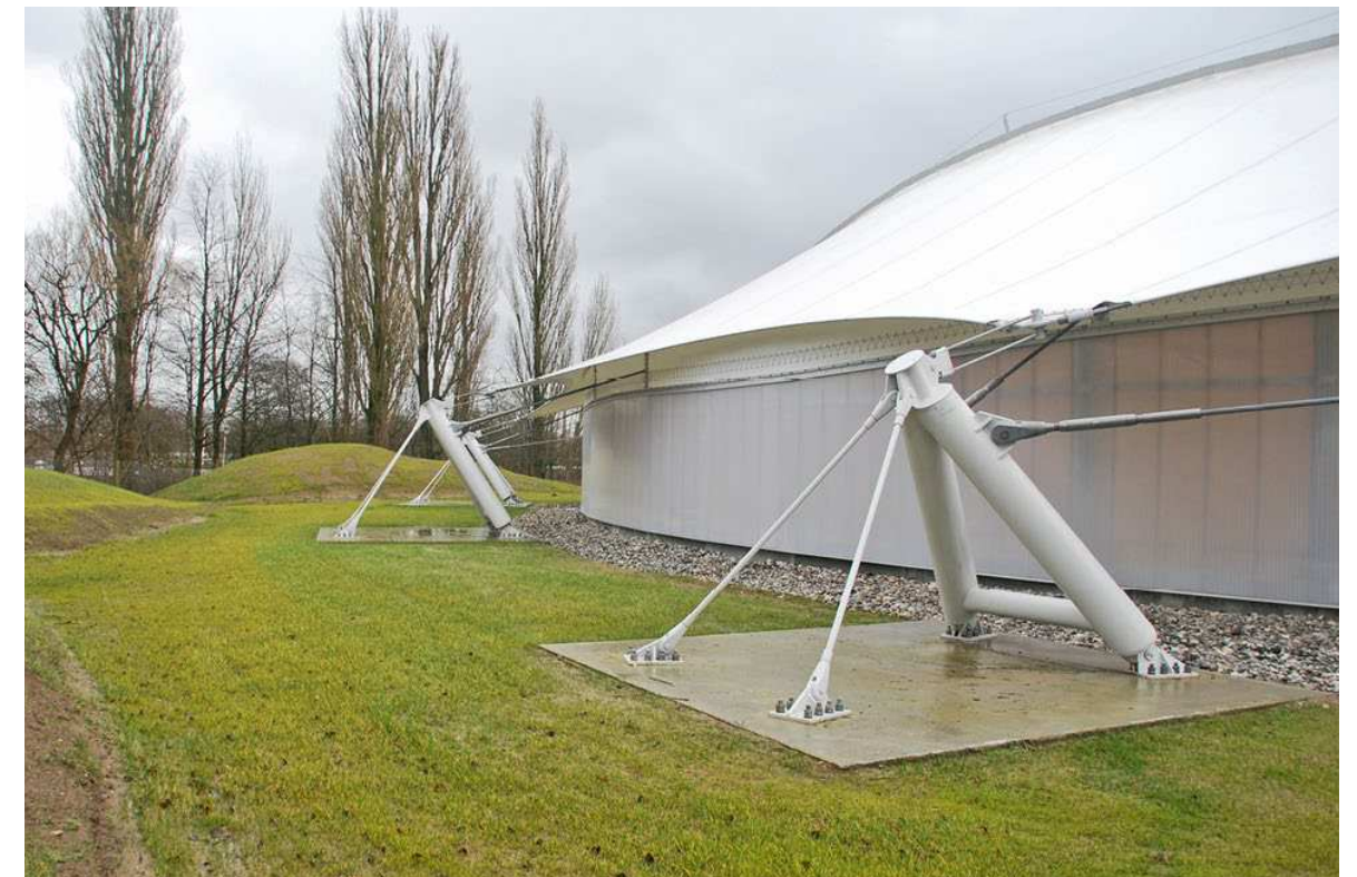
Teltdug som letvægtskonstruktion
