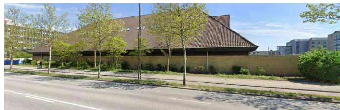
Facade mod Tuborgvej med havemuren
