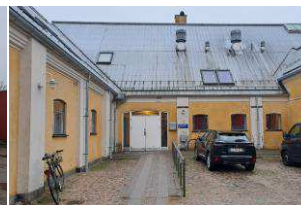
Hovedindgang og facade ind mod gårdsplads
