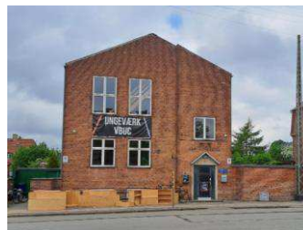
Facade og hovedindgang
