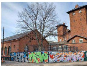
Ungeværk set fra Østbanegade
