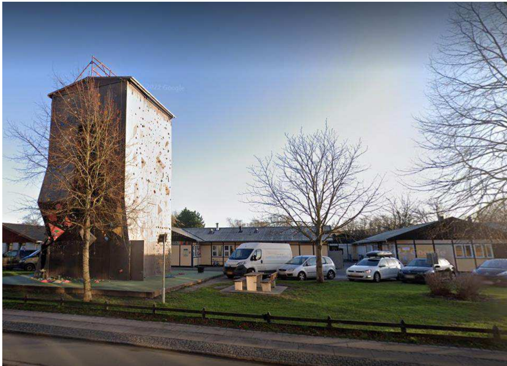
Ungeværkets klatretårn og hovedbygning set udefra
