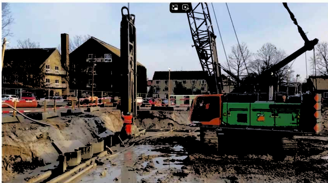
Figur 4-6 Illustration af byggeri udført med slidsevægge. Byggeri med slidsevægge anvendes til at udføre dybe skakte med stor styrke
