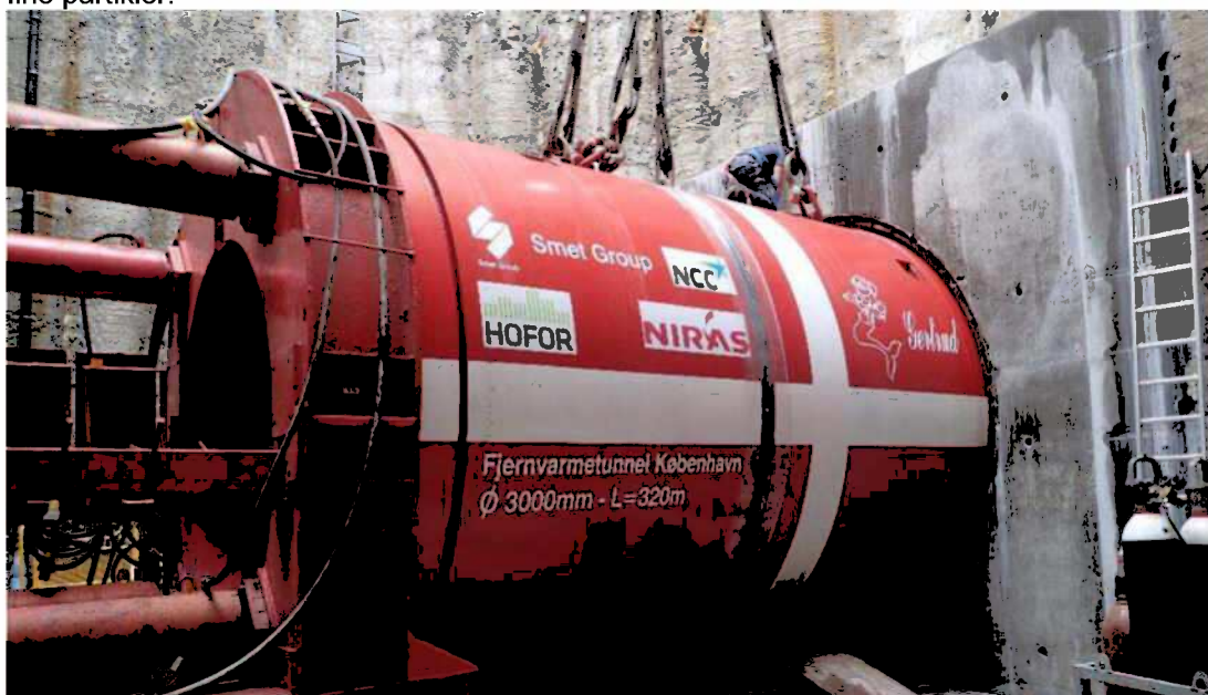
Figur 4-10 TBM er klar til pipe-jacking
