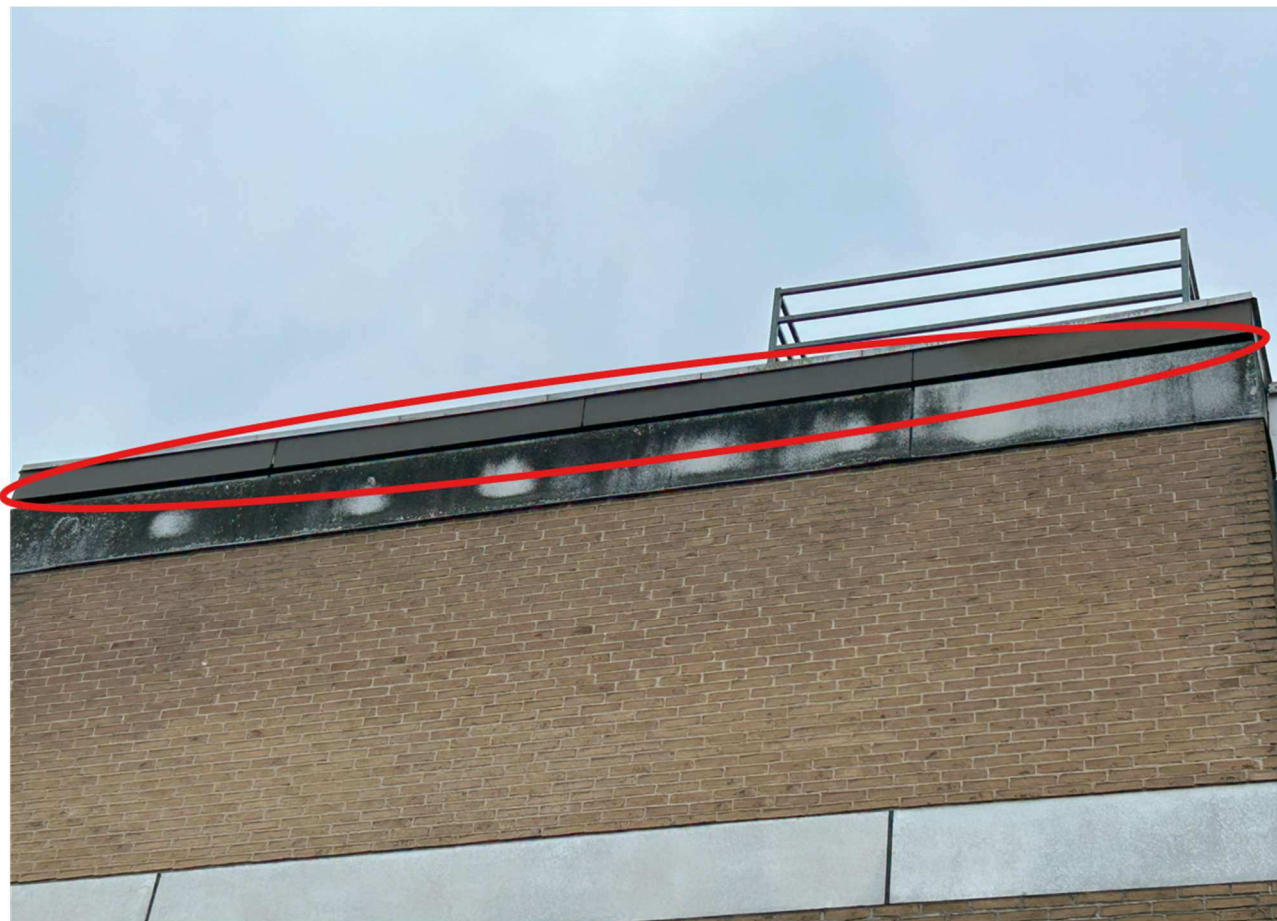
Figur 3-4 Foto af en af bygningerne ved Bystævneparken. Det vurderes at området omkring taget, kan have huller der kan give adgang til tagkonstruktionen.
