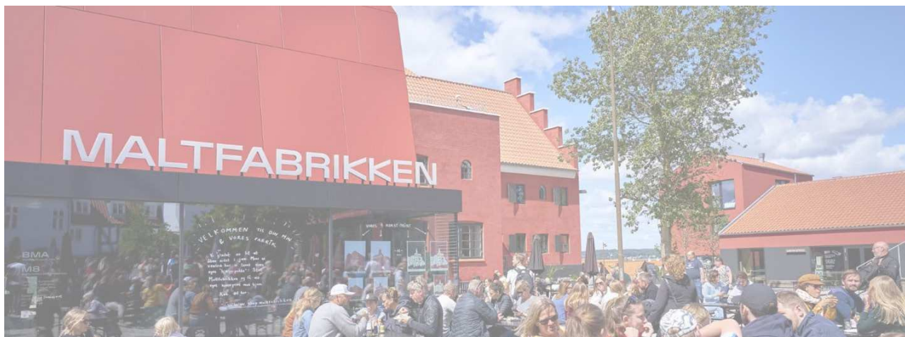
Maltfabrikken i Ebeltøft, bl.a. støttet af Realdania 2 . Inspiration til ombygning af industribygning.
