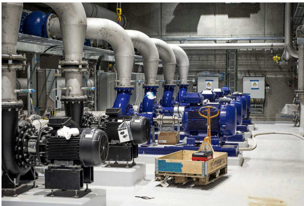
Figur 3. Foto fra Værket ved Søndersø, trykpumperne der skal sikre leverance af drikkevand til Tindhøj beholderanlæg.
