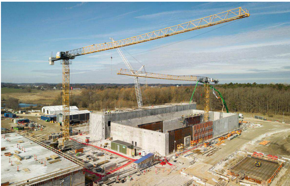
Figur 2. De i alt 12.000 m 3 store rentvandsbeholdere er nu opført på Danmarks største vandværk (her foto af færdiggørelse af mellemvæggen marts 2026)
