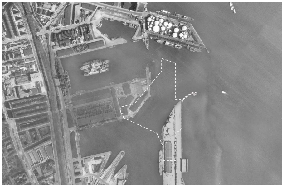
Luftfoto fra stedet (1954) med tidligere pakhuse og siloer inkl. afgrænsning af lokalplanområdet
