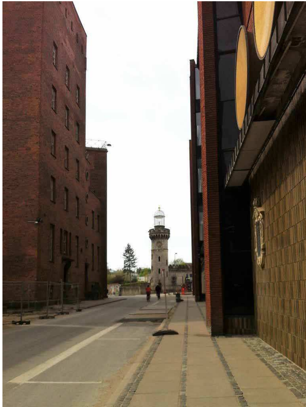
Pasteursvej mellem Vandtårnet og Hotel Otillia inden ombygning
