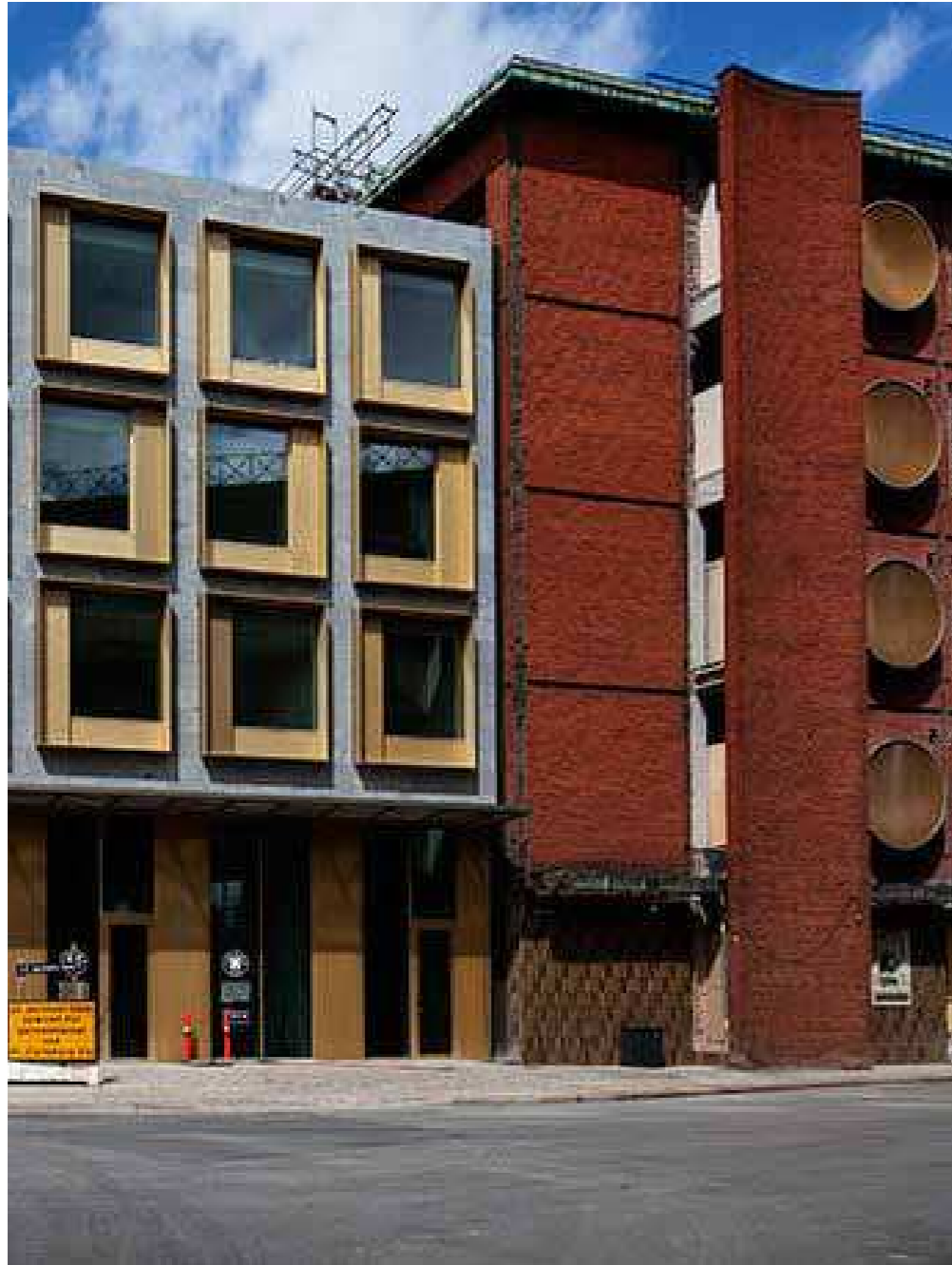
Ny kontorbygning i forlængelse af Hotel Otillia
