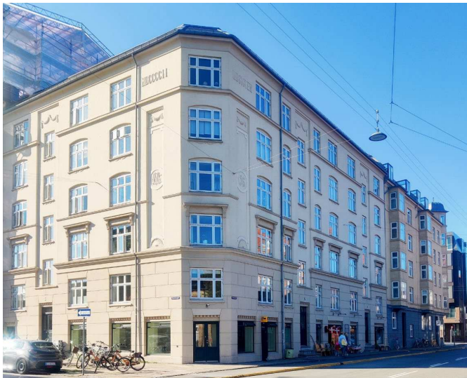
Andelsforeningen Udsigten set fra Kastrupvej.
