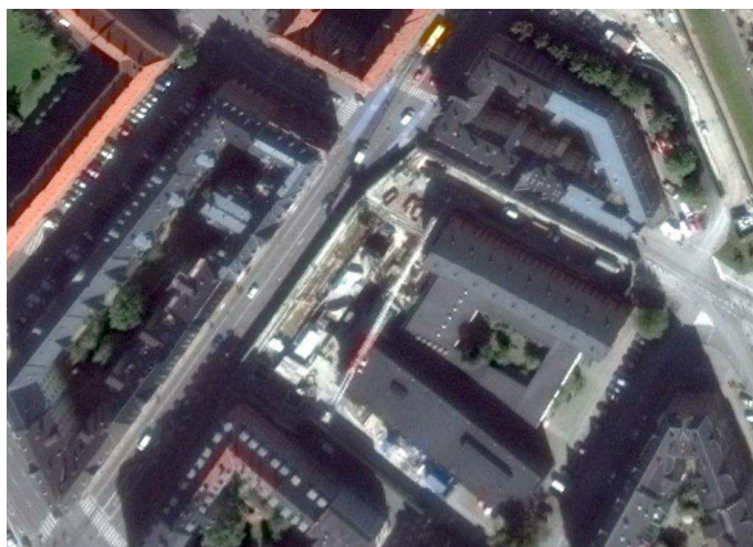
Figur 3-4 Udgravning til metrostation ved Nuucs Plads
