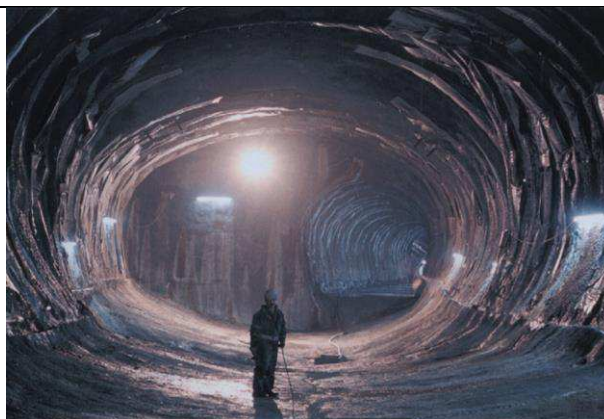
Figur 7-23 17 m bredt afgreningskammer i Københavns metro
