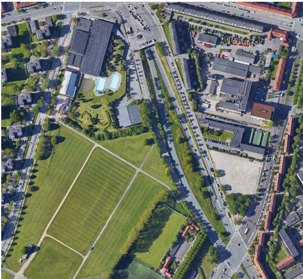
Figur 6-2 Frederikssundsvejtunnel Borups Allé og Hulgårdsvej
