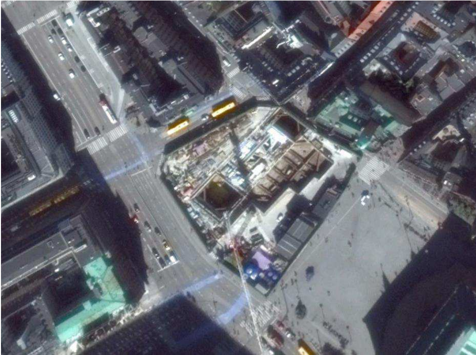
Figur 3-12 Udgravning til metrostation ved Rådhuspladsen
