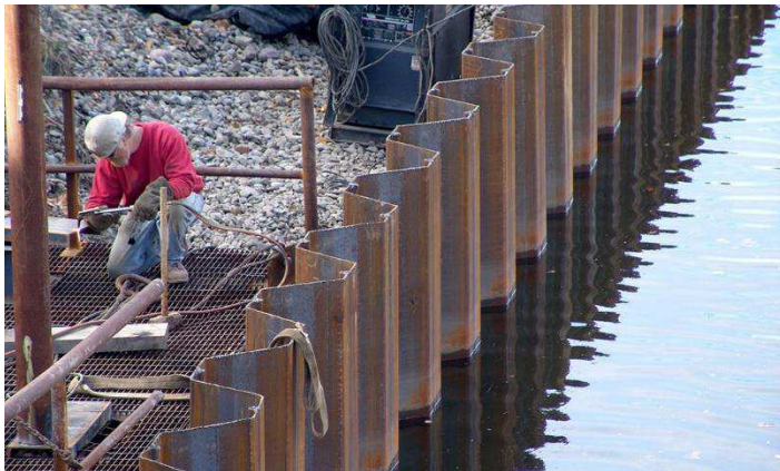
Figur 7-15 Byggegruber laves med spunsvægge for rampe konstruktioner
