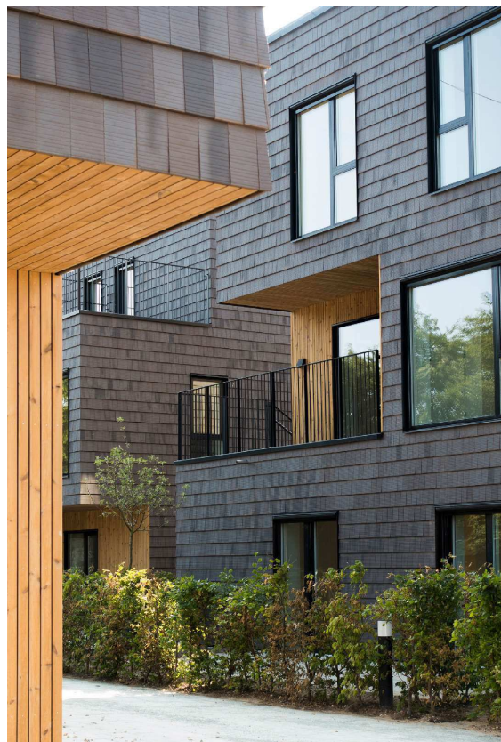
Balders Have i Ishøj er bygget med træ i de bærende konstruktioner og beklædt med tegl på facaden. Foto: ONV arkitekter / ia ia architechte
