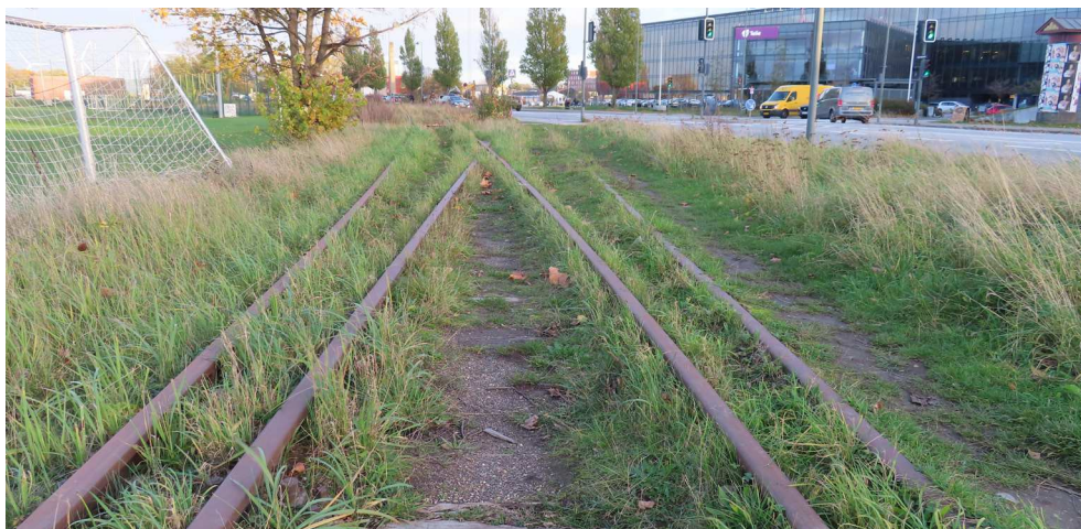
Sporskiftet, der delte banen mellem sidesporet til Prøvestenen og hovedruten sydover er stadig et tydeligt og bærende bevaringsværdigt kulturspor.
