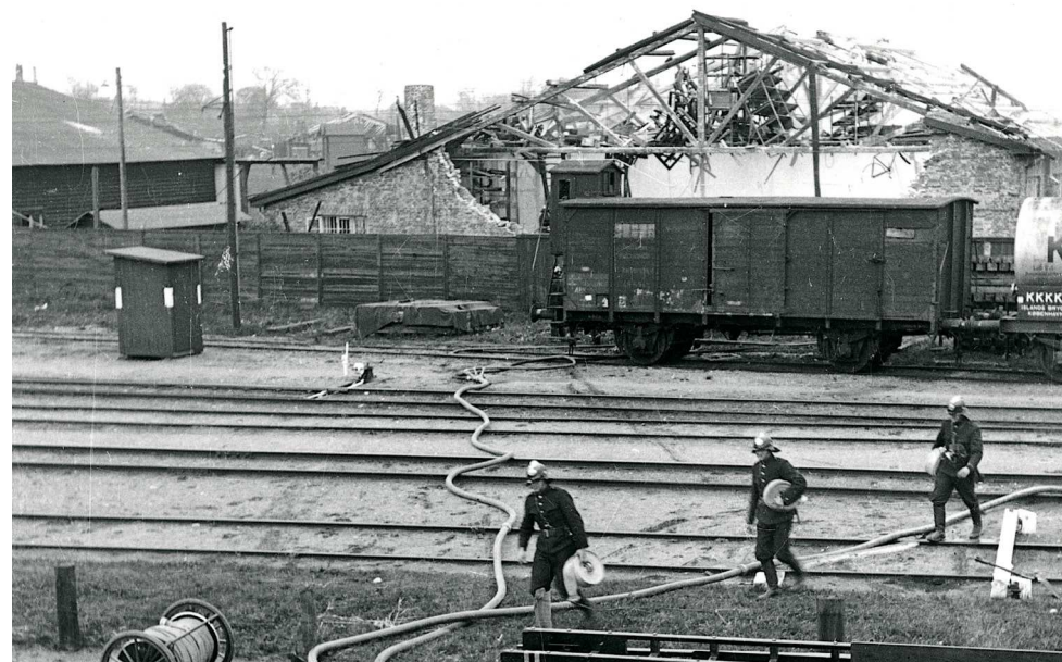
Ved en sabotage i december 1944 blev én af flyhangarerne langs banen sprængt. Både denne og nabohangaren blev så stærkt medtaget, at de måtte rives ned. Billedet er taget af sabotøren selv fra førstesalen i Uplandsgade 52 og giver et godt indtryk af sporområdet og nærheden til hangarerne. Foto: Frihedsmuseet
