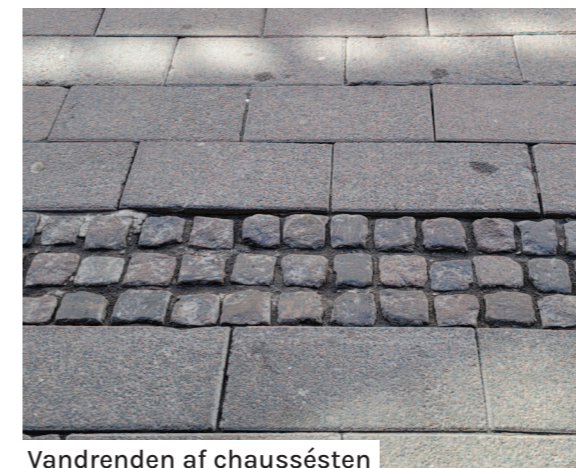
Vandrenden af chaussésten
