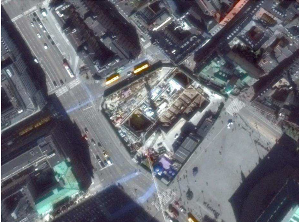
Figur 3-12 Udgravning til metrostation ved Rådhuspladsen
