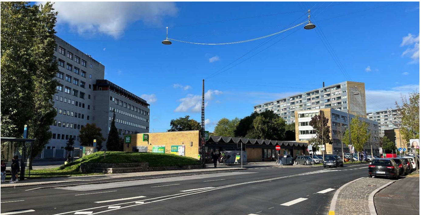
Lokalplanområdet set fra Borups Plads med den eksisterende dagligvarebutik i forgrunden og plejecentret Aftensol mod Lundtoftegade.
