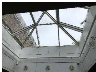
Lysskaft over platformen i midten af rummet.
