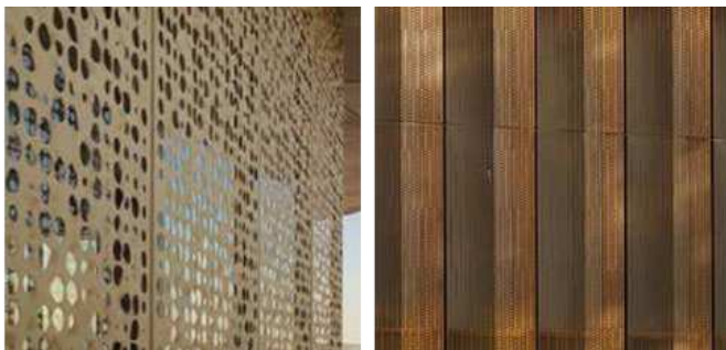
Eksempler på perforeret anodiseret aluminium. Ill. Arkitema.
