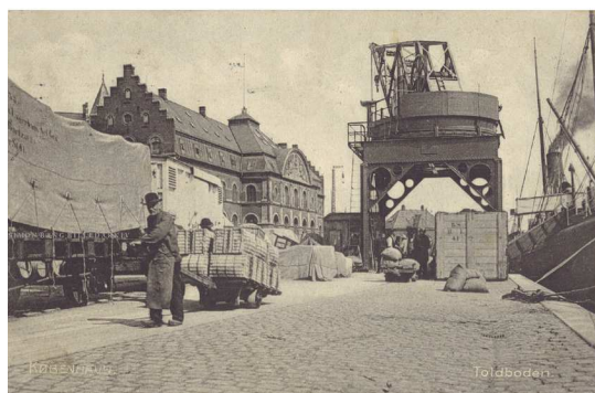
Billede 6 - Frilagerbygning. ca. 1905
