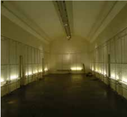
Den eksisterende kælder under pladsen.
