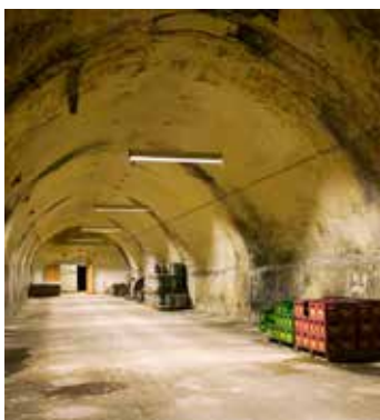
Kælderen under Rød Lagerbygning.
