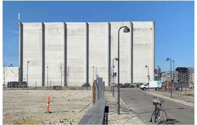
Cylindervej nord for lokalplantillægsområdet. Kig mod MAN Energy Solutions. Foto: TRUST
