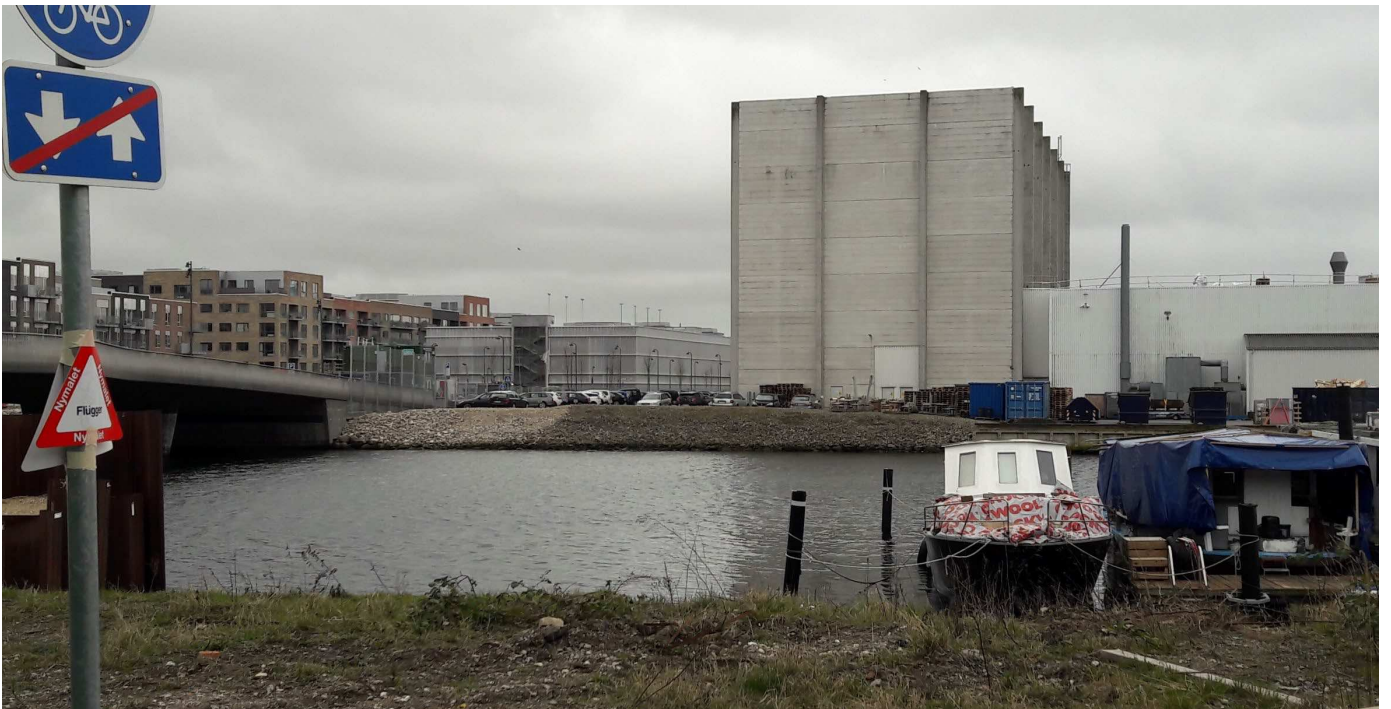
Området set fra Enghave Brygge med Man Energy Solutions og Alfred Nobels Bro. P-huset og boligkarréerne ses i baggrunden.
