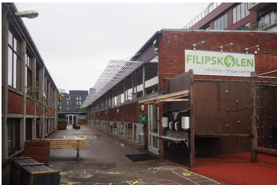
Amager Strandvej 124 bygning 1 og 3 set fra øst.
