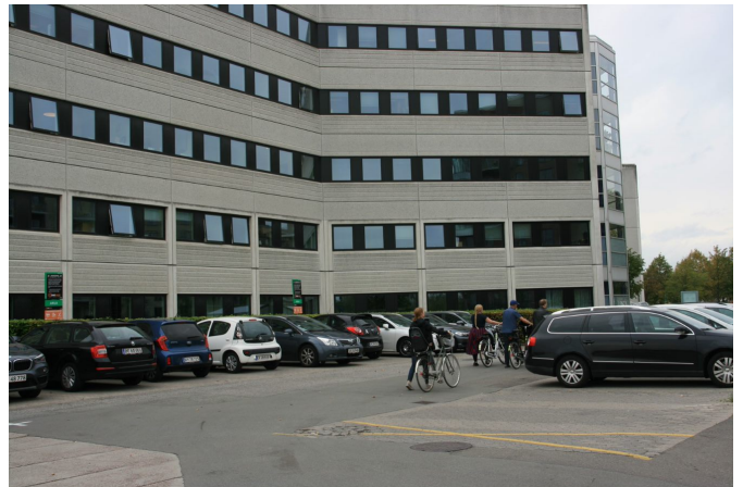
'Nauticonbygningen' set fra lokalplanområdet mod øst. 'Nauticonbygningen' er bygget i 1990'erne og huser forskellige erhvervskontorer.
