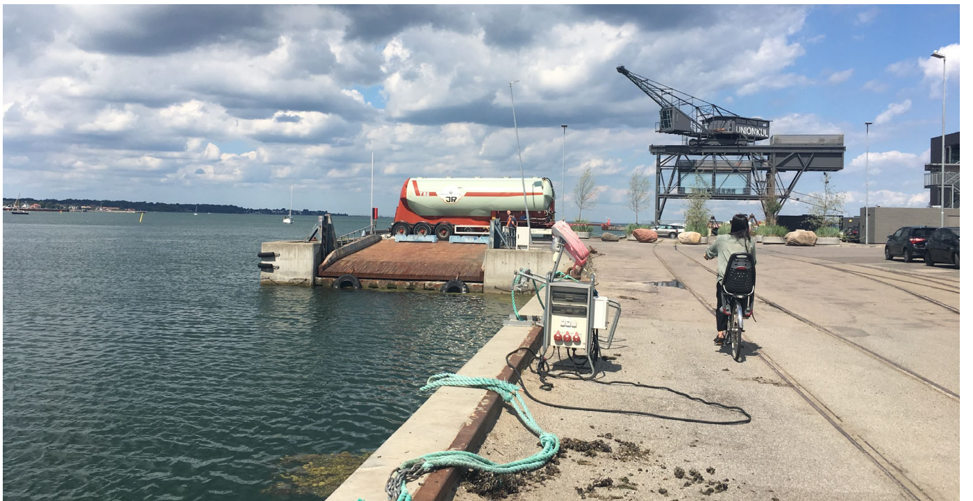
Fortøjningsringe, skinner og betonbolværker på kajen langs med Kalkbrænderiløbet. Midt i billedet ses 'færgestedet' som fremstår med en rampe af jern, og bagerst, uden for lokalplanområdet, den markante 'Unionkul Kran', der i dag bl.a. anvendes til conferencefacilliter.
