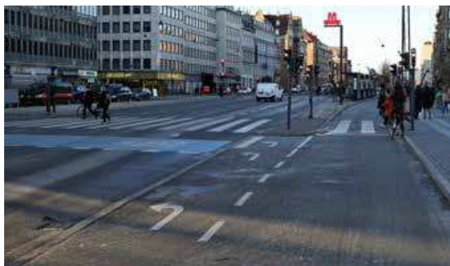
T-kryds med kanalisering og bred ligeudbane, H.C. Andersens Boulevard/Vesterbrogade
