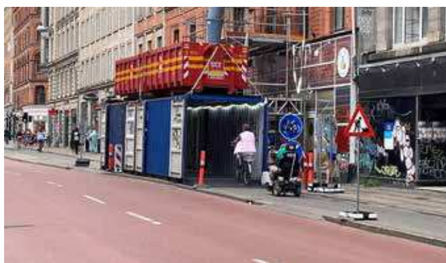
Belyst container til cyklister ved byggearbejde på Nørrebrogade
