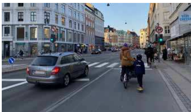
Fremført cykelsti og højresvingsforbud for bilister, Østerbrogade/Rosenvængets Allé
