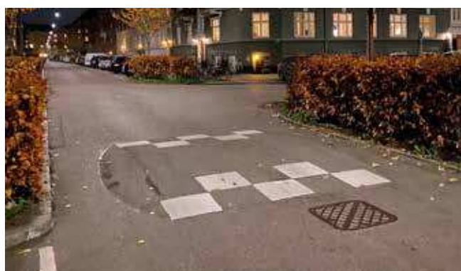
Bump og indsnævring på Julius Bloms gade
