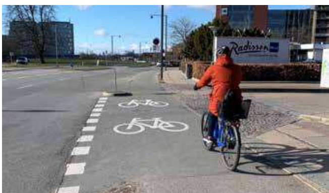
Halvt cykelfelt ved overkørsel på Ørestads Boulevard
