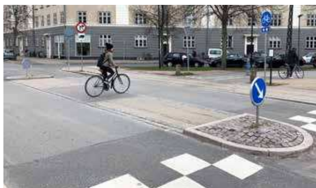
Cykelstikrydsning med midterhelle, Nørrebrodden/Stefansgade
