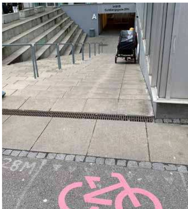
Cykelrampe ved KEAs cykelkælder
