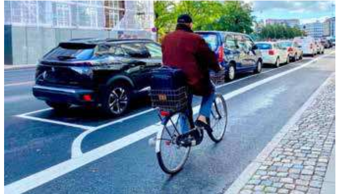
Afmærket sikkerhedszone, Vester Farimagsgade
