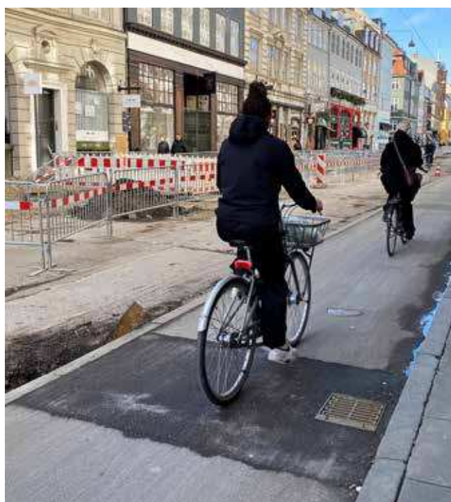
Reparation på hele cykelstibredden på Gothersgade
