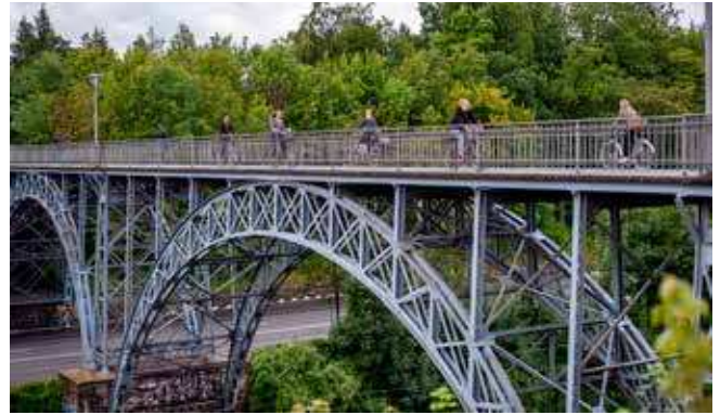
Carlsberg viadukten, foto Troels Heien
