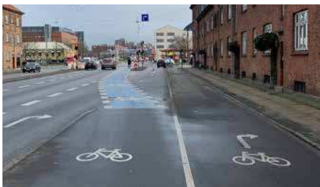
Cykelbane mellem ligeud- og højresvingsbane, P. Knudsens Gade/ Enghavevej
