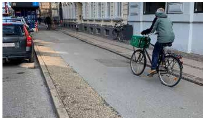
Sikkerhedszone med afvigende belægning, Niels Juels Gade
