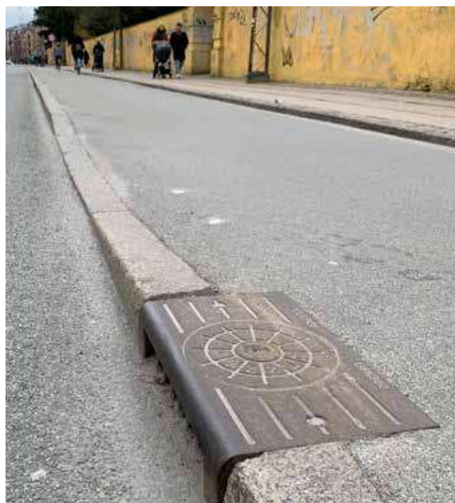
Dykket kantsten og sideindløbsbrønd på Nørrebrogade
