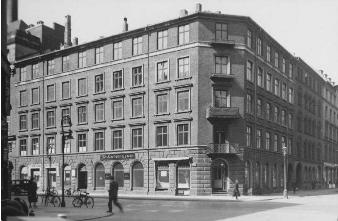
Hjørnet Tordenskjoldsgade 18 og Holbergsgade 3 Billede fra før 1839
