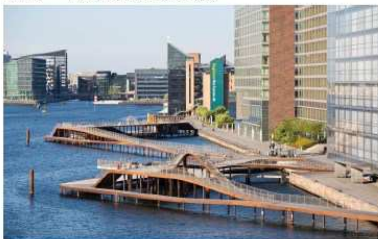
Figur 1-3 Foto af promenaden Kalvebod Bølge.
