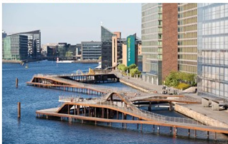
Figur 1-3 Foto af promenaden Kalvebod Bølge.
