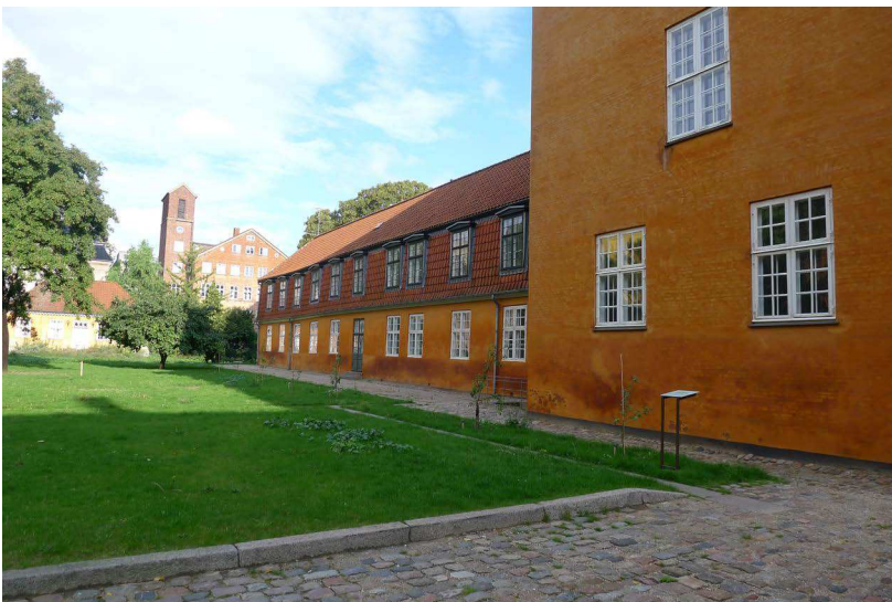
Amaliegade 23-25; Nr. 25, Sidehus 1, Sidehus 2 og Mansard sidehus
