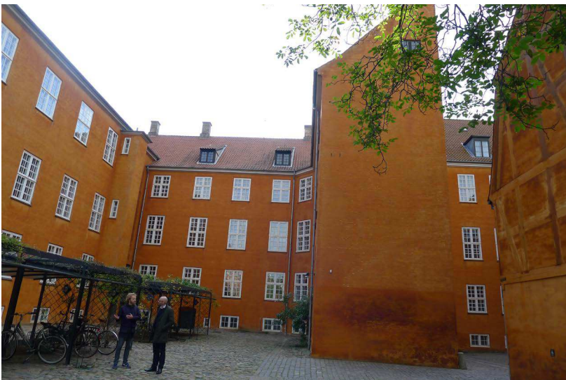
Amaliegade 23-25; Mellembygning, Gårdfacade og gavl af sidehus
