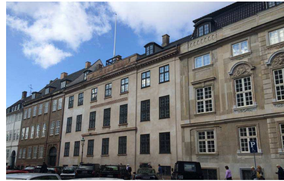
Amaliegade 23-25; Mellembygning, Gedefacade
