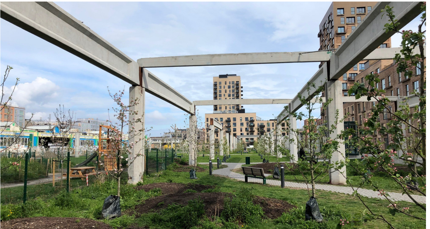
Frugtplantagen i Grønttorvsparken set fra vest. Dele af konstruktionen fra Grønttorvshallen er bevaret og fungerer både som et rumskabende og skalaformidende element mellem mennesker og høje bygninger.
