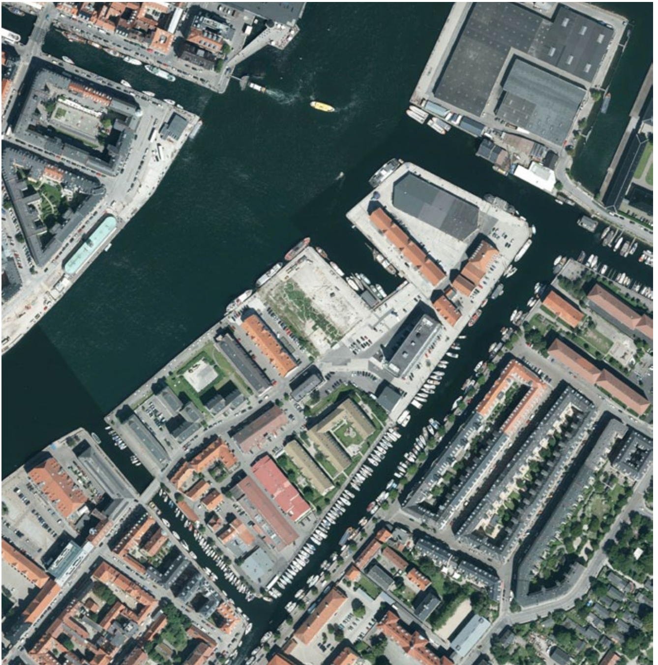
Luftfoto af lokalplanområdet og omgivelser. Foto er taget i 2011, før DR Aftenshowet blev flyttet fra Nyhavn til Krøyers Plads og før bygningen på Grønlandske Handels Plads blev revet ned.
